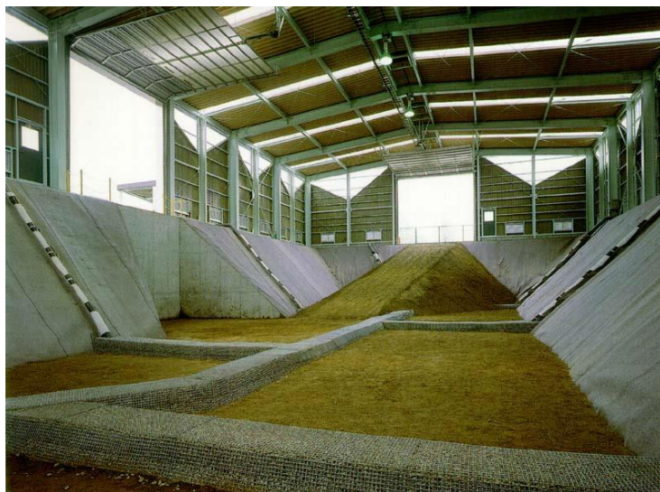
写真1-1 日本初の被覆型最終処分場 3)
