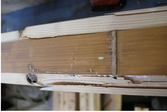
写真9：WT試験体の破断面の状況（下面）
