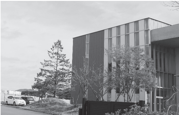
三次元半導体研究センター外観
