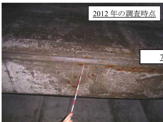
写真 5-4 塩害の短期間における鋼材腐食の進行情形
