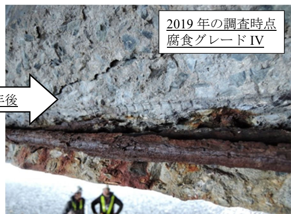
写真 5-4 塩害の短期間における鋼材腐食の進行情形
