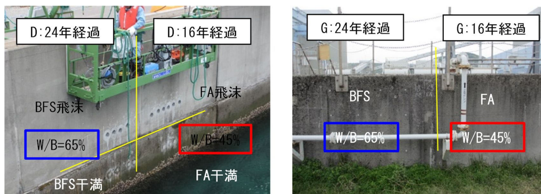
写真 6-2 構造物 D, G の状況
