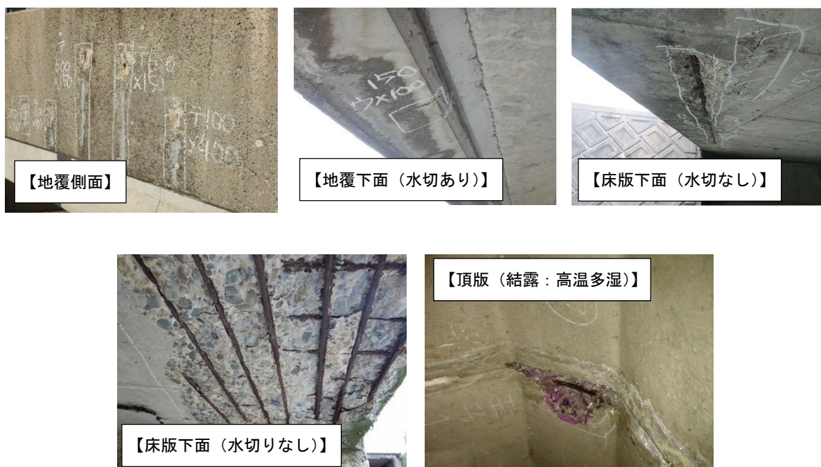
写真 2-4 中性化による損傷事例
