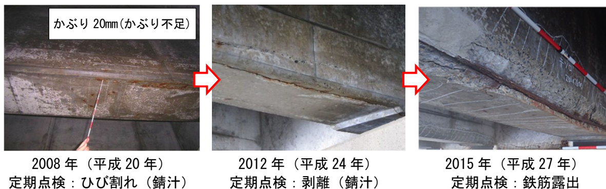
写真 2-3 塩害の短期間における劣化進行事例
