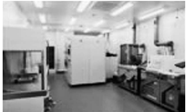
図4：クリーンルーム
