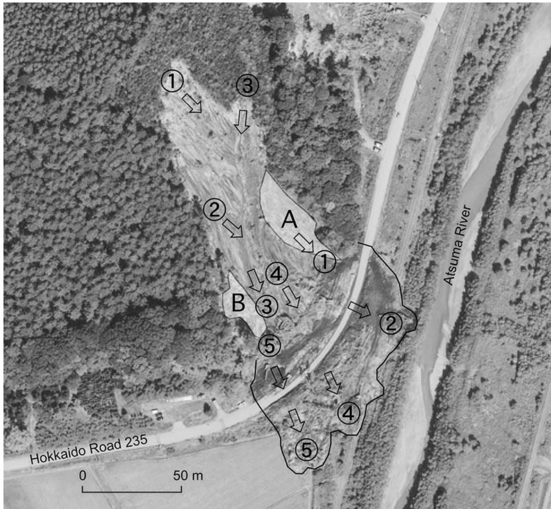
図8 空中写真でみる地形から推定される桜丘地区での崩壊順序 (奥野ほか, 2019a, b). 丸数字と矢印は、切り合い関係から推定される崩壊順序を示す。AとBは、崩壊堆積物が薄く覆うエリアを示す。Aは主に①の崩壊堆積物に、Bは③の崩壊堆積物に覆われる。国土地理院の空中写真 (2018年9月11日撮影) を基図として利用した。
