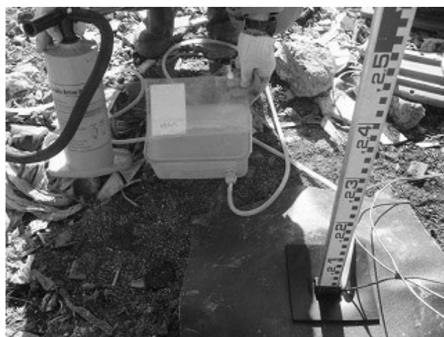
写真 - 4.8 ボーリング孔内ガス採取状況
