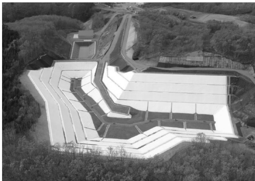
写真 - 2.12 計測実験対象とした最終処分場（施設整備時）
