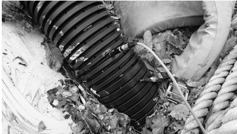
写真 - 2.16 ガス抜き管内の環境測定状況 1
