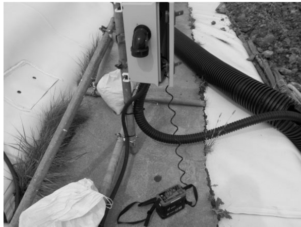
写真 - 2.15 硫化水素測定状況 2
