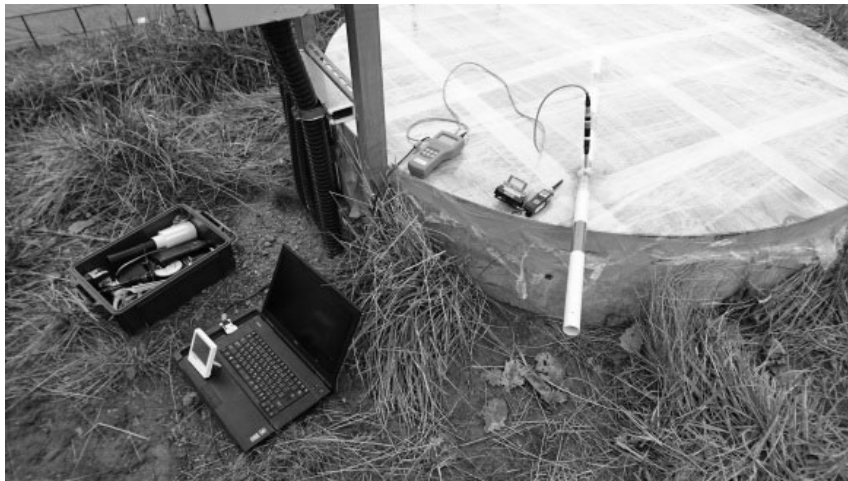
写真 - 2.20 集水ピットの密閉状況
