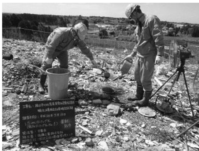
写真 - 4.7 ボーリング孔への資材撒布状況
