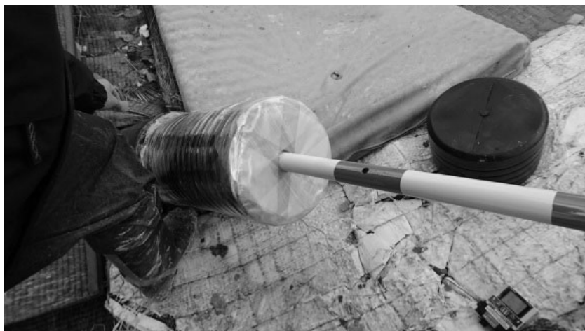
写真 - 2.18 ガス抜き管内の環境測定状況 3
