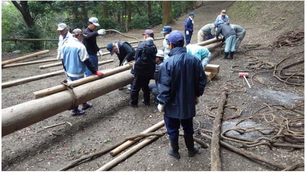
1 本目の添え木の取り付け作業
