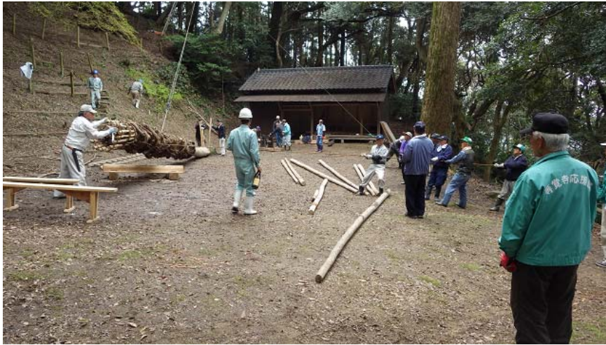
松柱を立てる作業
