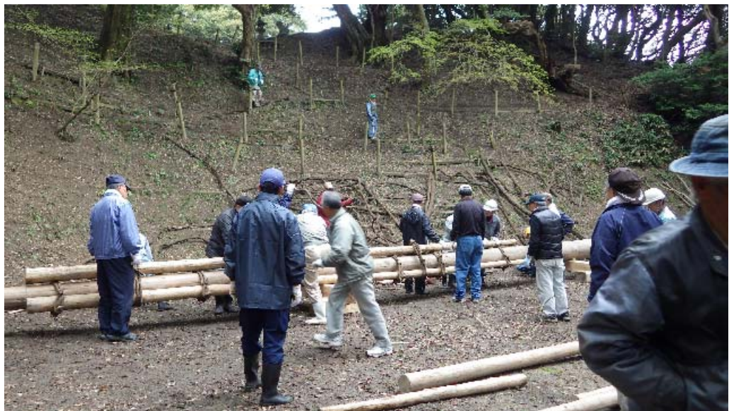
2 本目の添え木の取り付け作業
