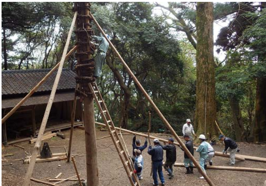
8本ほどの突支棒により自立する松柱
