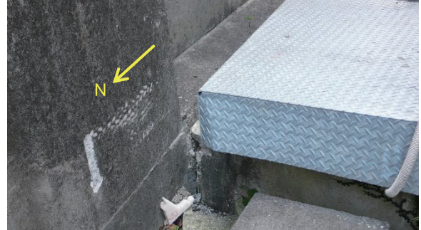
写真 2.9 クリアランスカバーの接触痕 (a 棟)
