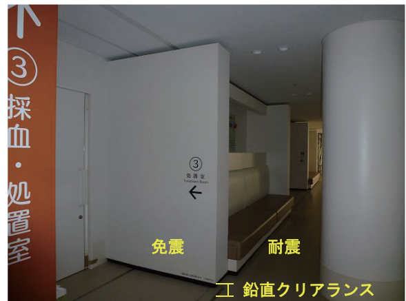
写真 5.5 室内のエキスパンションジョイント
