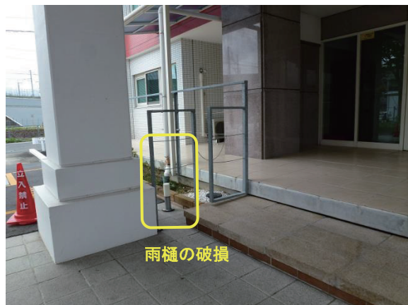
写真4.4 建物外周部の様子
