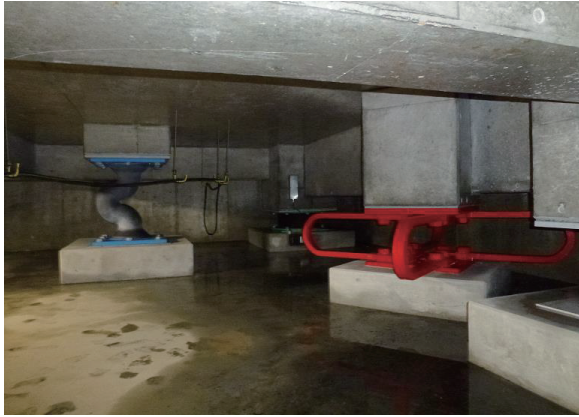
写真 4.6 免震層の様子
