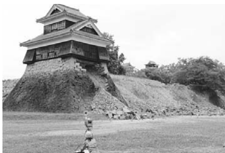
図6 地上レーザ測量（西出丸付近）
