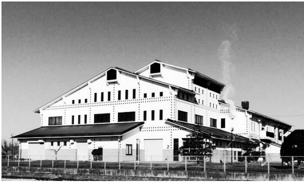
図3 実証実験を実施したし尿処理施設
