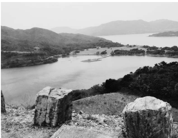
図3 ハイアイランド貯水湖東ダムの南端部。左手崖のさらに向こう側が図2の位置。正面は南シナ海（2016年3月15日撮影）。このダムは香港最大の貯水量を誇る。もともと入り江になっていた地形の海側を塞ぎダムとした。1979年に完成。
