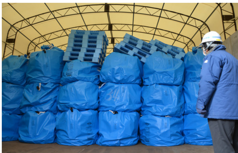
写真-5.1 放射性物質に汚染された焼却灰の保管状況
