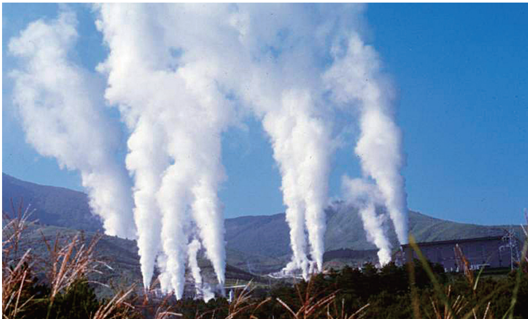
写真7. 大分県, 八丁原地熱発電所の5.5万KWの発電に利用されている蒸気の大気放出. 2年に1回タービンのメンテナンス時に発電に用いる蒸気が放出され, 通常, このような蒸気の放出は見られない. 八丁原地熱発電所の北東側から1984年撮影.
