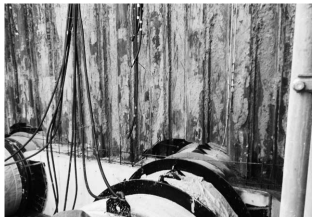
写真2 鋼板遮水壁貫通部
