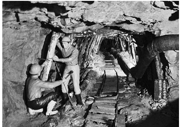
本山五坑坑道内部 (金瓜石)
