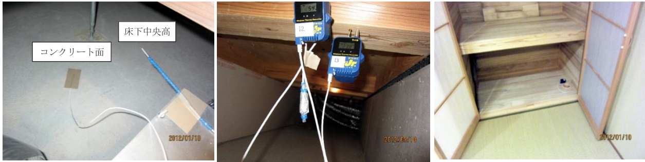
a) 床下中央高の温湿度及び床下点検口のコンクリート面の温度 b) 和室中央高の温湿度及びコンクリート面の温度 c) 和室の納戸の温度 (円形の排気口)
