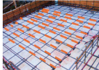
(注1) A種押出法ポリスチレンフォーム保温板3種(厚・50mm)
