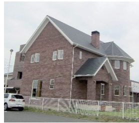
写真1 南西面からのレンガ貼りの戸建て木造住宅の外観
