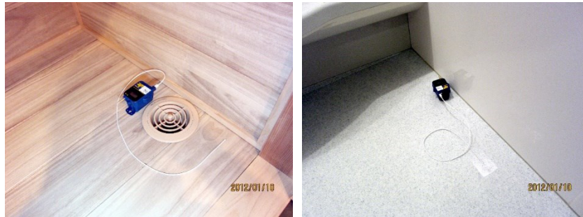
d) 納戸の温度 (円形の排気口) e) 浴室の床面の温度
