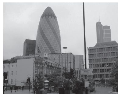
写真1-1 建物ガーキン外観と周辺
