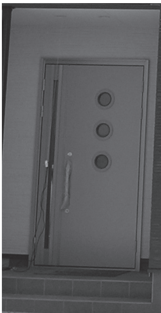
写真1 外気（玄関前のポーチに設置）（K邸）
