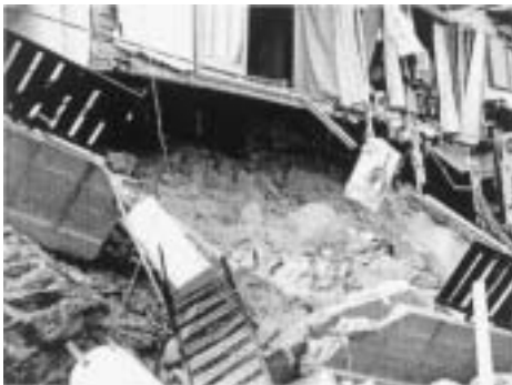
図14 玄界島被害写真
