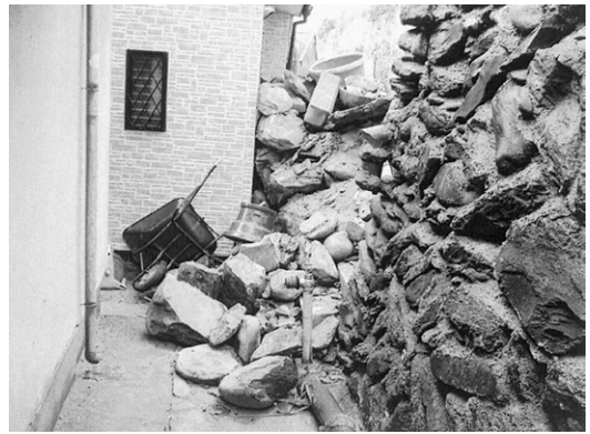
図12 擁壁の被害
