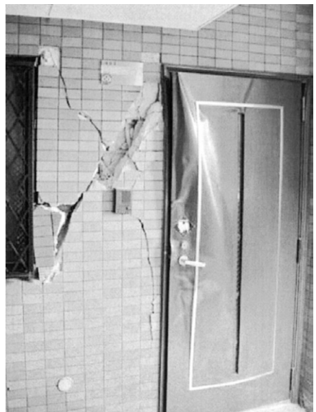
図7 マンションのドア開閉不能
