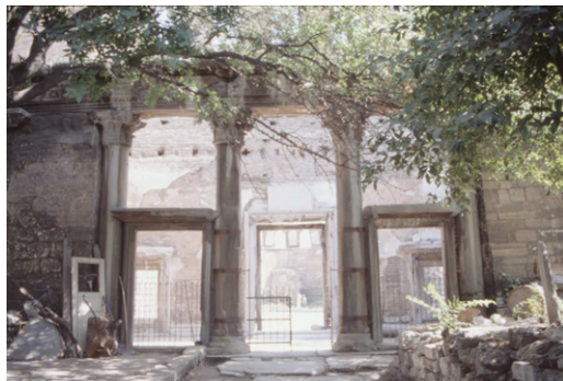
写真2 ストゥディオス修道院聖堂の入口 アトリウムより室内を望む(1992年:筆者撮影)
