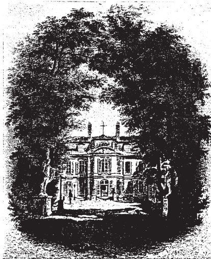
ENTRÉE DE L'HÔTEL AGUADO. Actuellement Mairie, rue Drouot.
